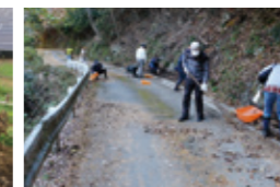
崩土の除去作業(11月27日)
