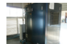
木工場コンプレッサーの更新
