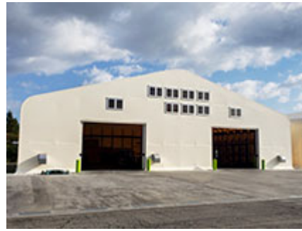
新設したテント倉庫
