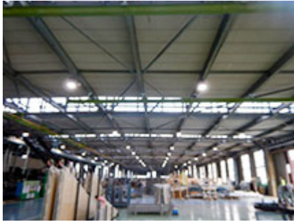
照明のLED化（第1木工場）
