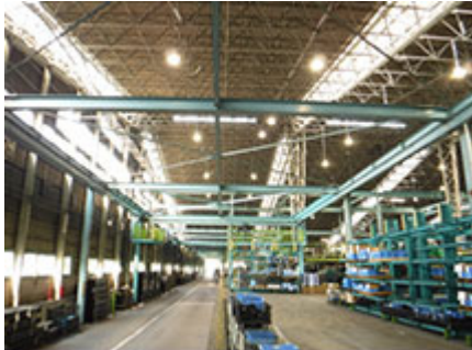
第1工場天井照明のLED化
