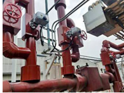
蒸気自動開閉弁設置
