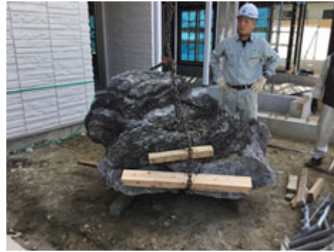
思い出の景石 施工中
