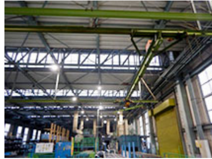
照明のLED化（第3パネル工場）
