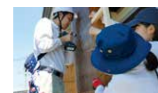
仮設住宅の風除壁設置作業
