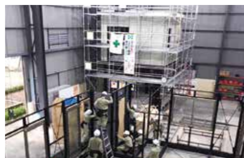
ベトナム・ハノイでの外装躯体施工訓練
