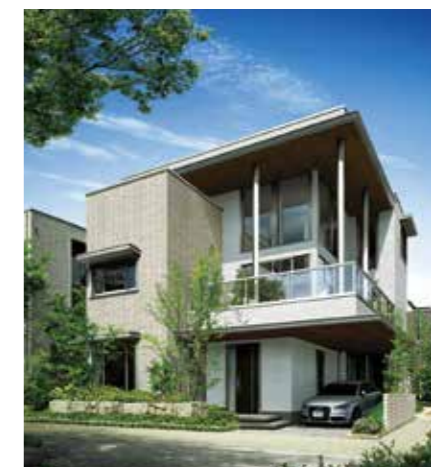
2層上の大屋根を支えるピロティ柱により開放的なバルコニー空間と大容量太陽光パネル設置を両立
