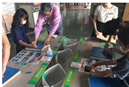
畳の解体作業を体験中
