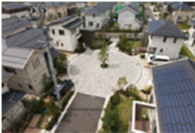
①防災スマートハウス
