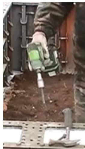
回転させながら引き抜くことで、ピンを簡単に取り外すことができる
