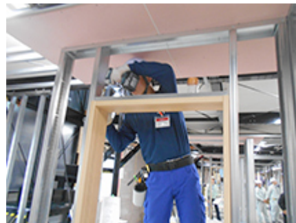
「内装施工コース」修了実技試験 (出入枠の施工)
