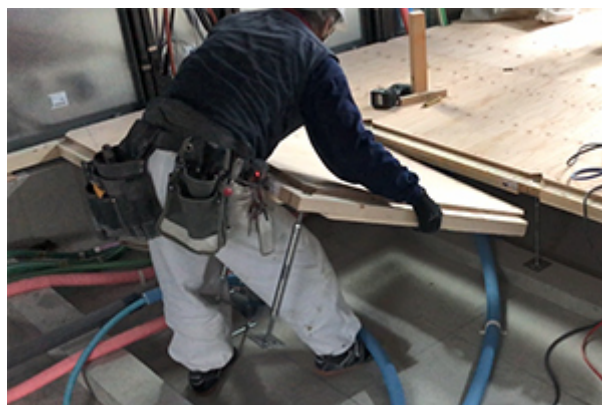
省力化と工期短縮を目指しつつ、安全性の向上も進めています
