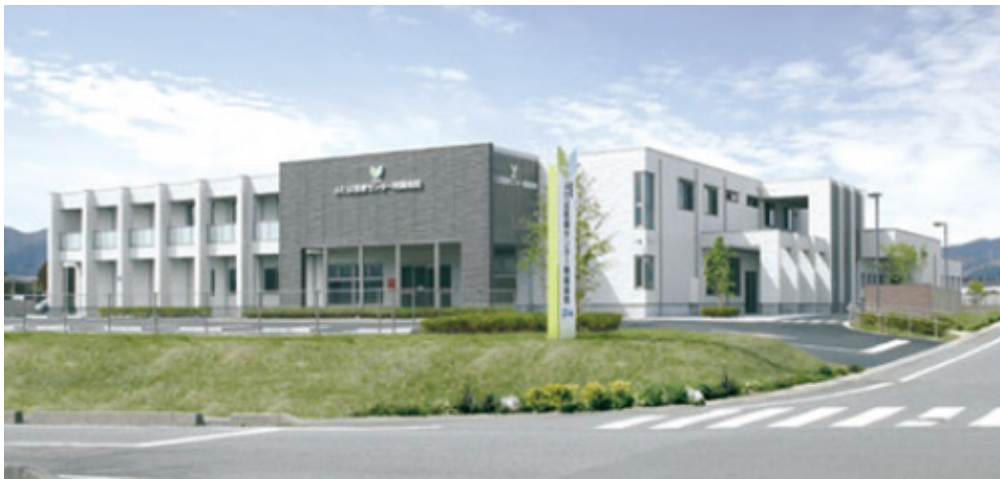
フレキシブルβシステムで建築した病院（ふたば医療センター附属病院・福島県）
