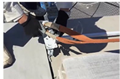
敷き込み後、シェルシャットスラブ間の隙 間から吊具を外すことができる
