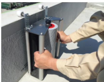
専用治具による施工
