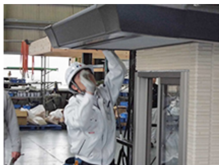
「躯体外装コース」修了実技試験 (軒天の施工)
