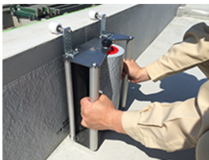
専用治具による施工
