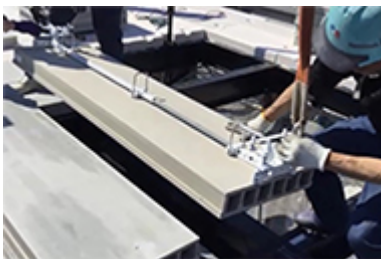
シェルシャットスラブの短辺方向中空穴に 治具の爪部を入れて吊り上げる
