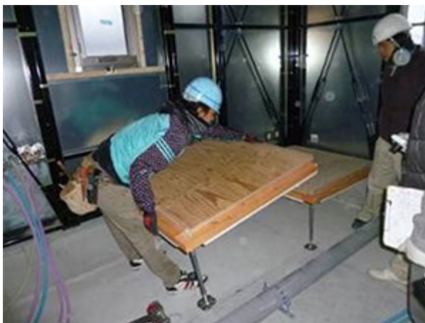
省力化と工期短縮を目指しつつ、安全性の向上も進めています
