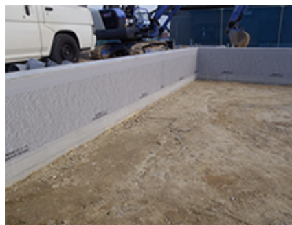
施工仕上がり状況
