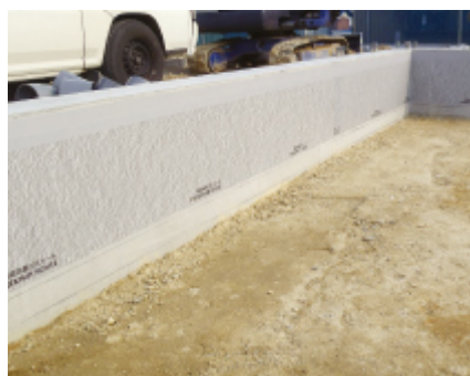
仕上がり状況
