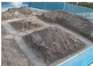
戸建住宅での施工例
