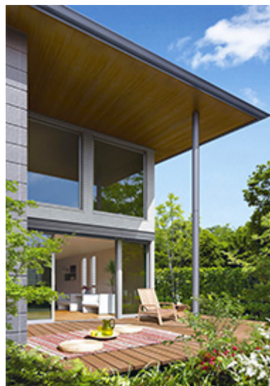
視野の広がり確保する1・2階通しピロティ柱
