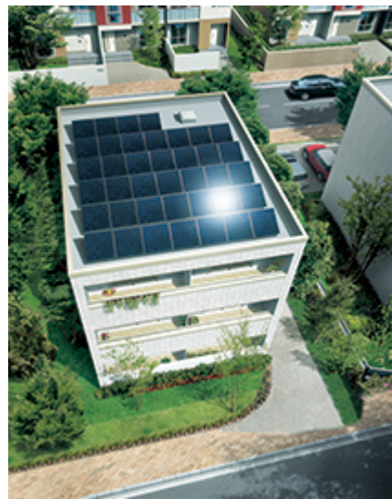
据え置き型太陽光パネル
