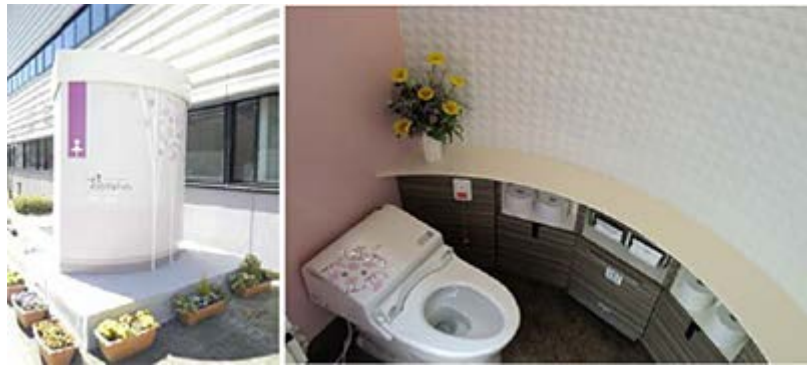
おりひめトイレ（左：外観、右：室内）
