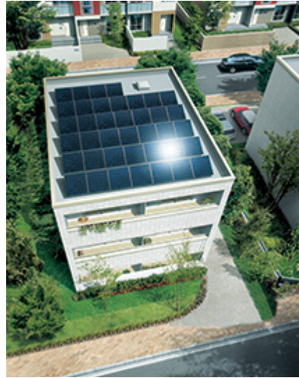
据え置き型太陽光パネル
