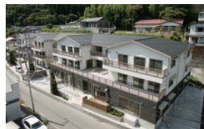
岩手県釜石市小白浜地区 災害公営住宅
