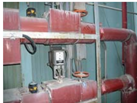
養生槽にストップバルブ設置
