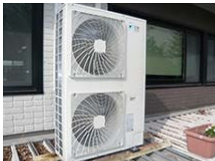
空調設備の更新
