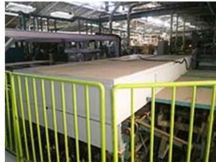
断熱塗料塗布による乾燥炉熱損失の防止
