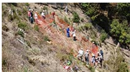
古くなった階段の補修作業
