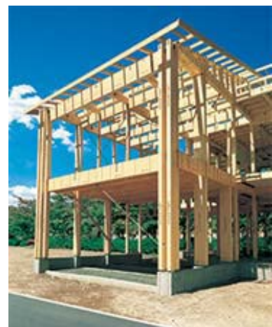
3方向開口や2台並列のビルトインガレージなどのプランを可能にする「木質ラーメンフレーム」
