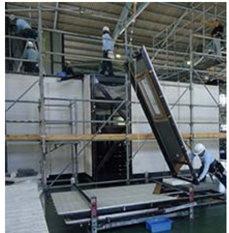
「躯体外装コース」の2階複合外壁施工(玉掛け)実習
