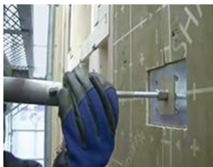
壁つなぎ材を手すりに取り付け、壁つなぎプレートのナット部と接続
