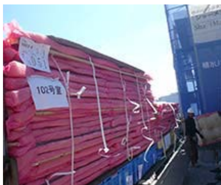
内壁枠への世帯番号表示。10の部材群に対し、積載山や部材への世帯番号表示を実施するようになり、部材の仕分けや間配り作業の効率が格段に向上しました
