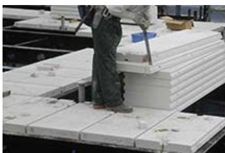
従来、現場での加工は労力を要し、切断片や切断粉が散乱していました
