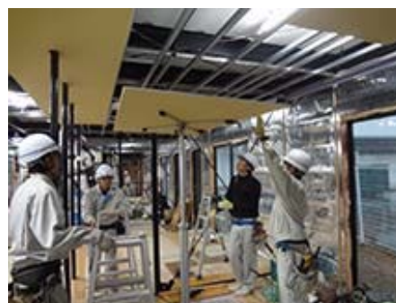
「内装施工コース」の天井石膏ボード施工実習
