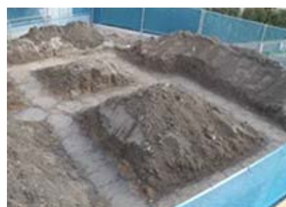
戸建住宅での施工例
