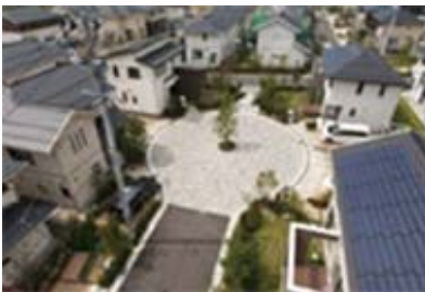
① 防災スマートハウス
