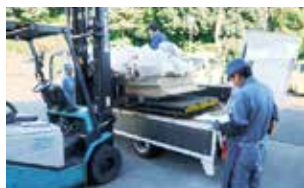
リフォーム廃棄物の搬入状況
