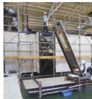
「躯体外装コース」の2階複合外壁施工(玉掛け)実習
