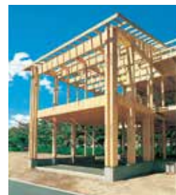
3方向開口や2台並列のビルトインガレージなどのプランを可能にする「木質ラーメンフレーム」
