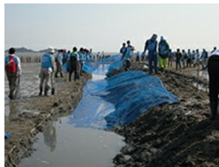
被覆網の設置
