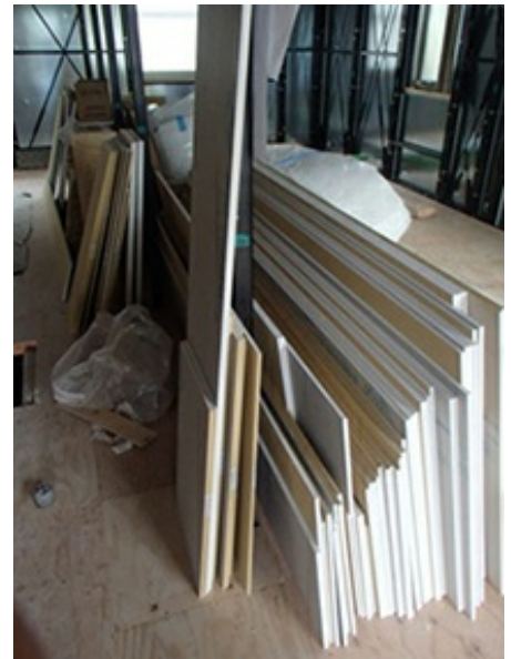
石膏ボードプレカット
