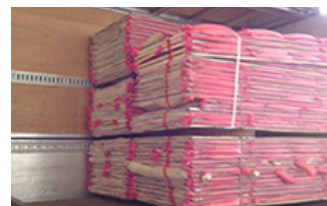
内装下地材積載方法の変更 (2段積みから3段積みに変更)
