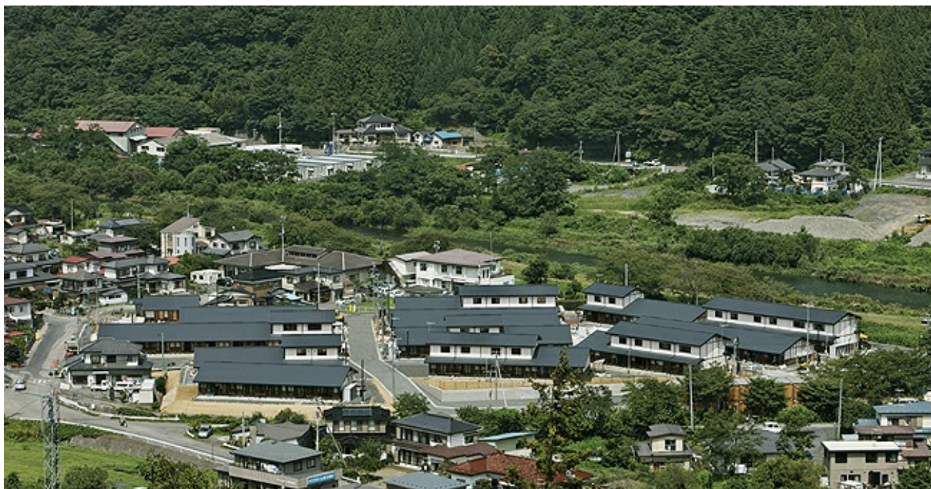
岩手県大槌町「災害公営住宅」
