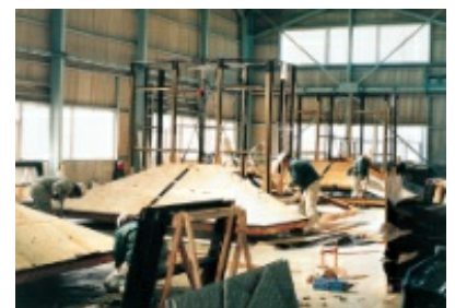
均質で高精度な施工を実現するには、施工従事者の職能教育も重要
