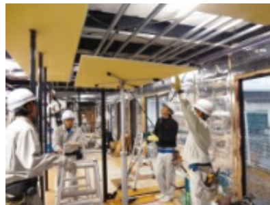
内装組立技能者を育成する「内装課程」の天井石こうボード施工実習
