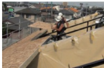
母屋野地パネルなどの大型部材についても複合化を推進
