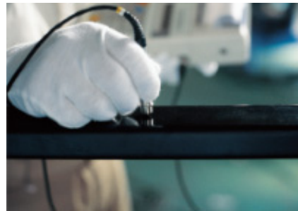
鉄骨防錆塗装厚検査
