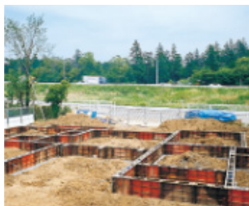
鋼製型枠「メタルフォーム」により、技能に左右されがちな基礎工事の均質・高精度化を実現
