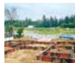
鋼製型枠「メタルフォーム」により、技能に左右されがちな基礎工事の均質・高精度化を実現
