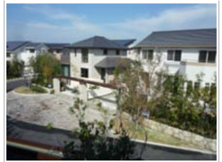
「照葉スマートタウン」まちなみ
