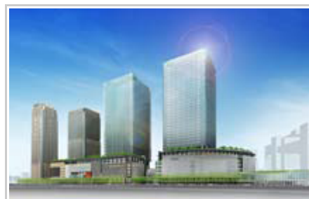
「グランフロント大阪」全景
