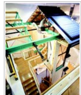
実物大カットモデルで、構造体の見えない部分を確認
