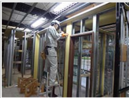
「内装課程」出入枠施工実習
