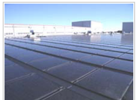
工場屋根への設置例
