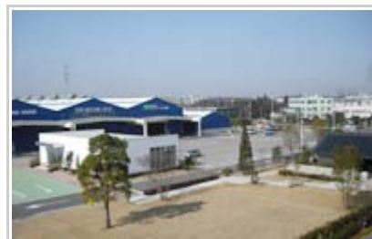
「ゼロエミッションセンター」全景 画面右が「ゼロエミッションハウス」 左の白い建物は「ウェルカムホール」 左奥は「資源循環センター」
