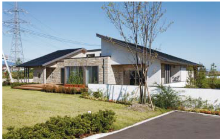
16.3kWの太陽光発電システムを搭載したコミュニティセンター。停電時に日中最大4.5kWの電力を供給します
