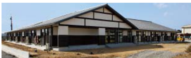
福島県相馬市災害公営住宅
