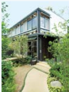
縁側空間や通気天窗など、自然を取り込み、快適に暮らす工夫を随所に盛り込んでいます
