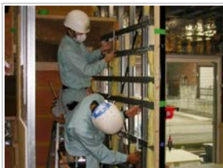
「内装課程」階段施工実習
