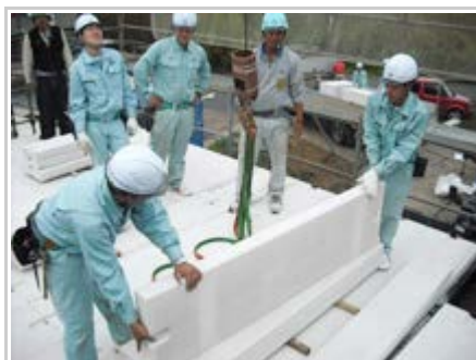
「普通課程」現場実習(建方)
