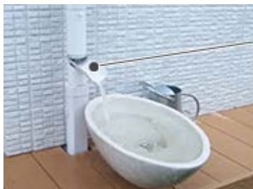
雨水取り出し口『パッコン』の設置例
