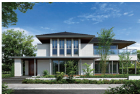
鉄骨2階建て住宅「イズ・ロイエ」
