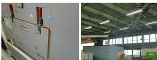
乾燥炉断熱の実施
