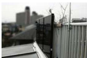
ソーラーシステム実証実験 屋上すすり外側に温水パネルを設置。
