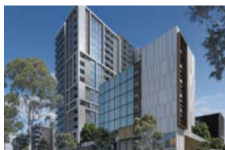
ウェントワースポイント タイガ棟 372戸
