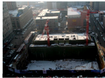
瀋陽・和平区マンション
