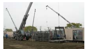
仮設住宅建設の様子
