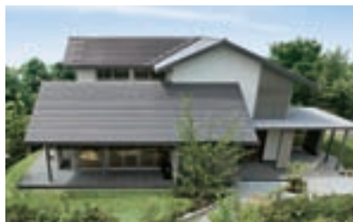
切妻屋根によるシルエット
