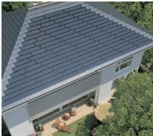
屋根形状に合わせて効率よく敷き詰められた瓦一体型太陽光発電システム
