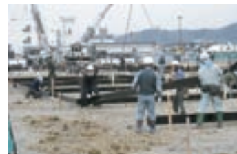
急ピッチで進む仮設住宅の建設
