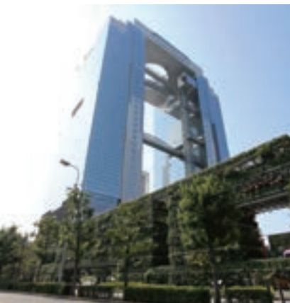
「希望の壁」高さ9m、長さ78m、奥行3m
