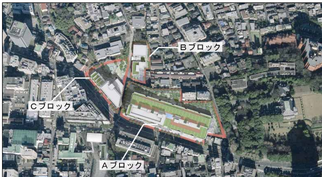
A・B・Cブロック 航空写真
