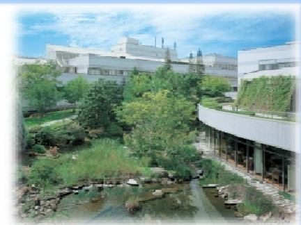
総合住宅研究所(京都府木津川市)
